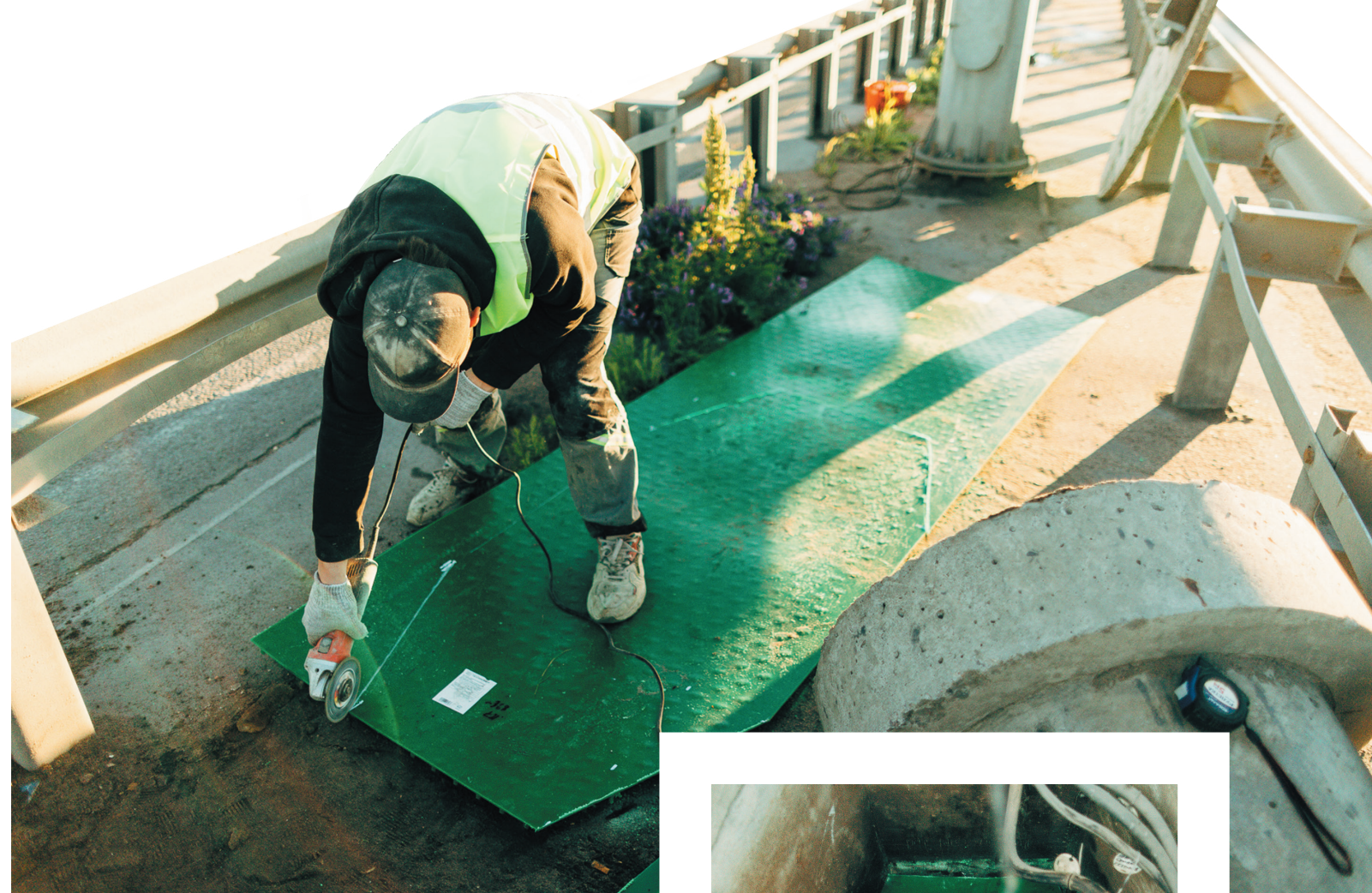
Работа бригады «ГИС» на Киевском шоссе
