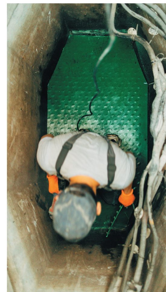
Установка анкерного полимерного листа «ЭКОВЭЛЛ» на дно колодца
