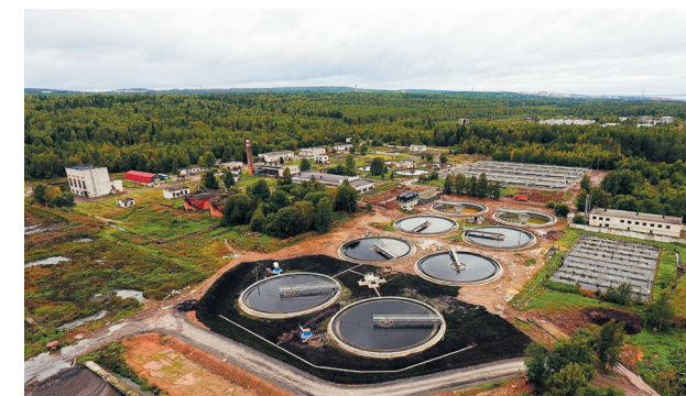
Петрозаводск Санация 16 резервуаров
